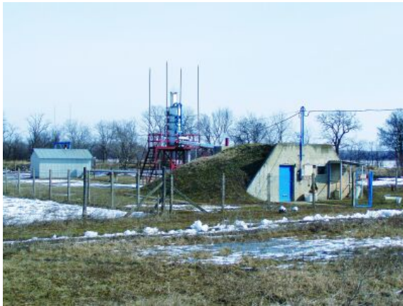
gáztalanító és szivattyúház
